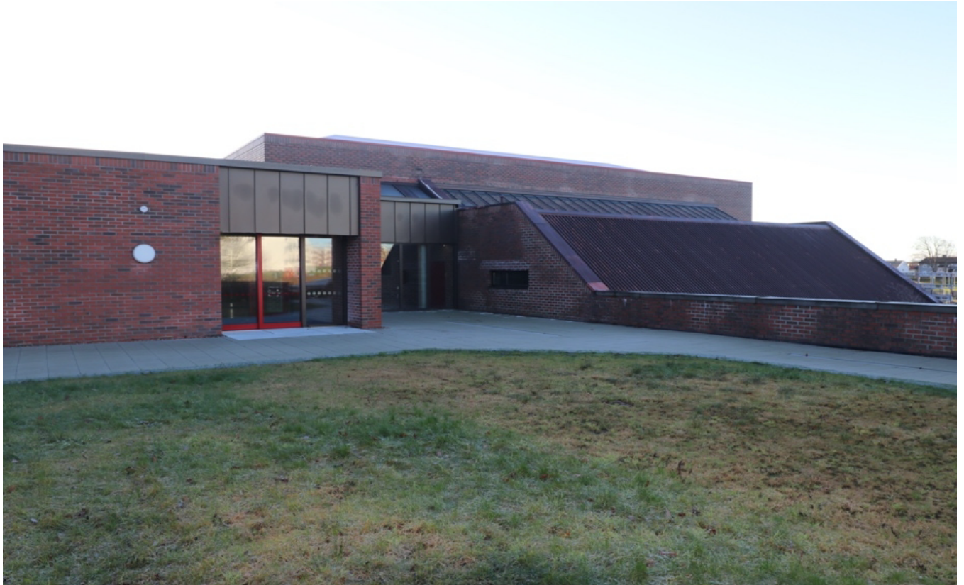
Figur 1 Nordsiden av hall. Viser overgang mellom opprinnelig del (høyre) og utvidelsen (venstre) med sideinngang til indre korridor mellom ny og opprinnelig del.
