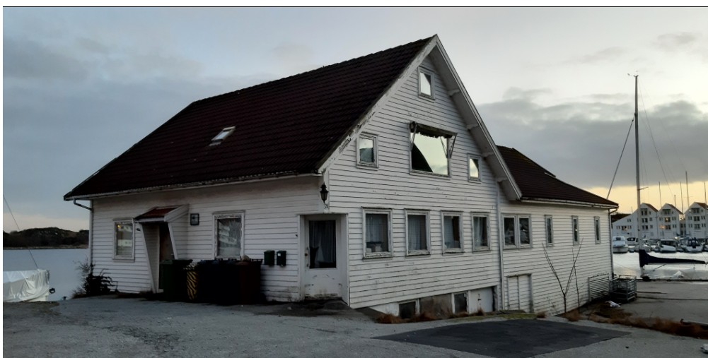
Figur 5 Olsahuset sett fra Havnevegen, foto: Rogfk
